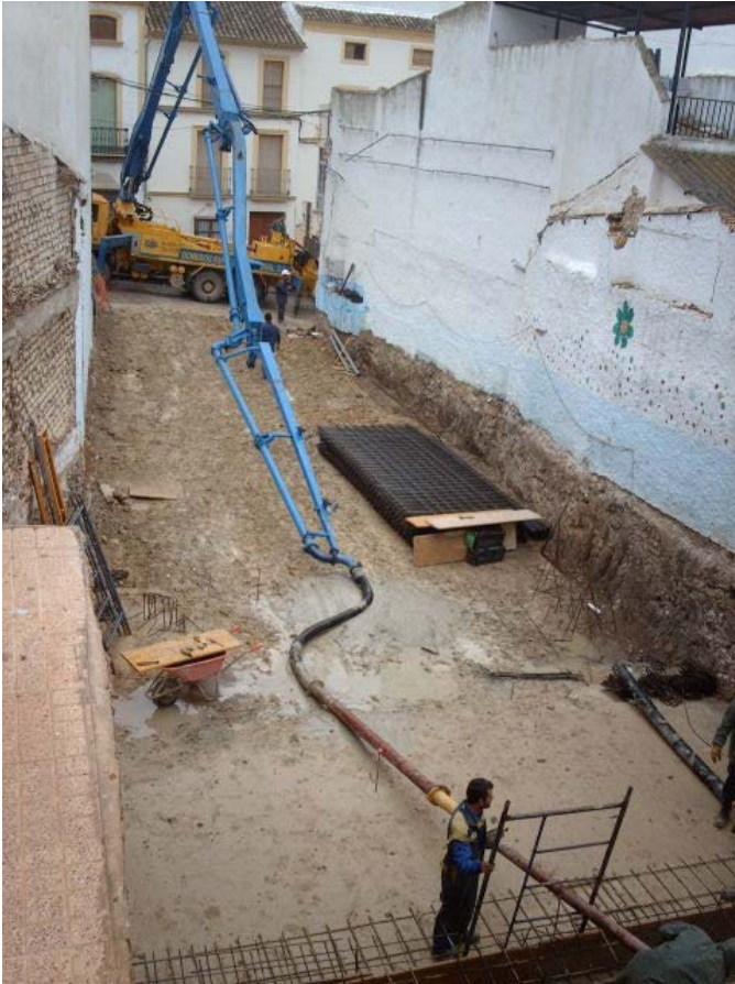
Imagen de la ejecución de muros de contención.
