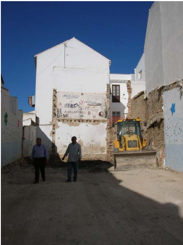
Imagen de la demolición y movimiento de tierras.
