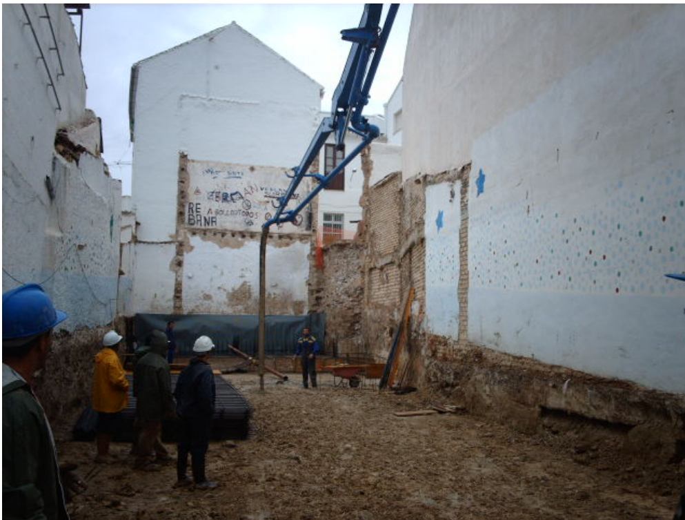
Imagen de la ejecución de muros de contención
